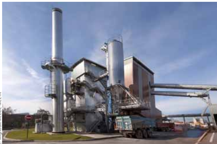
Chaufferie biomasse à Cergy (95)
