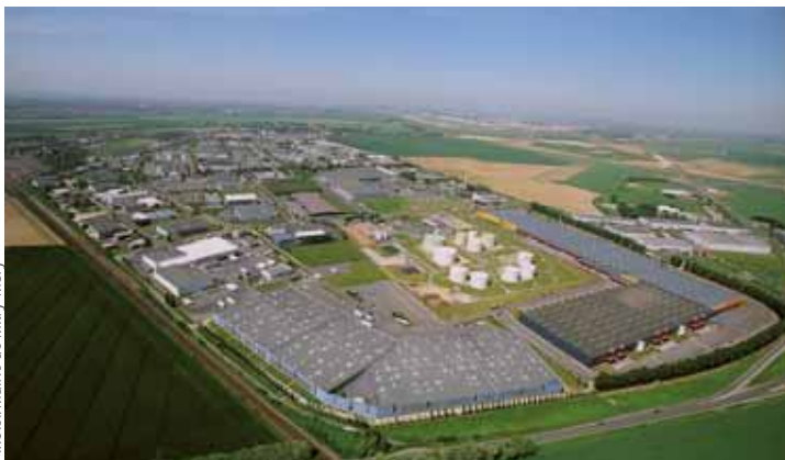
Dépôts d'hydrocarbures CCMP sur la zone industrielle de Mitry-Compans
