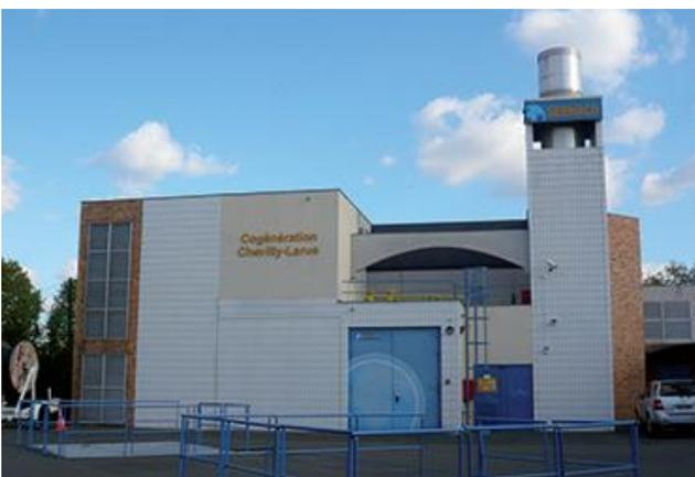
**À Chevilly-Larue**, une eau pompée à 2 km de profondeur et à 74 °C, chauffe 21 000 logements et une piscine. Cela remplace une centaine de grosses chaufferies et 30 % d'économies. Le bâtiment se situe en centre-ville. La réalisation du forage initial nécessite une surface libre de 5 000 m<sup>2</sup> pour l'installation du chantier, mais la centrale de géothermie n'occupe que quelques centaines de m<sup>2</sup> et ne génère aucune nuisance.
