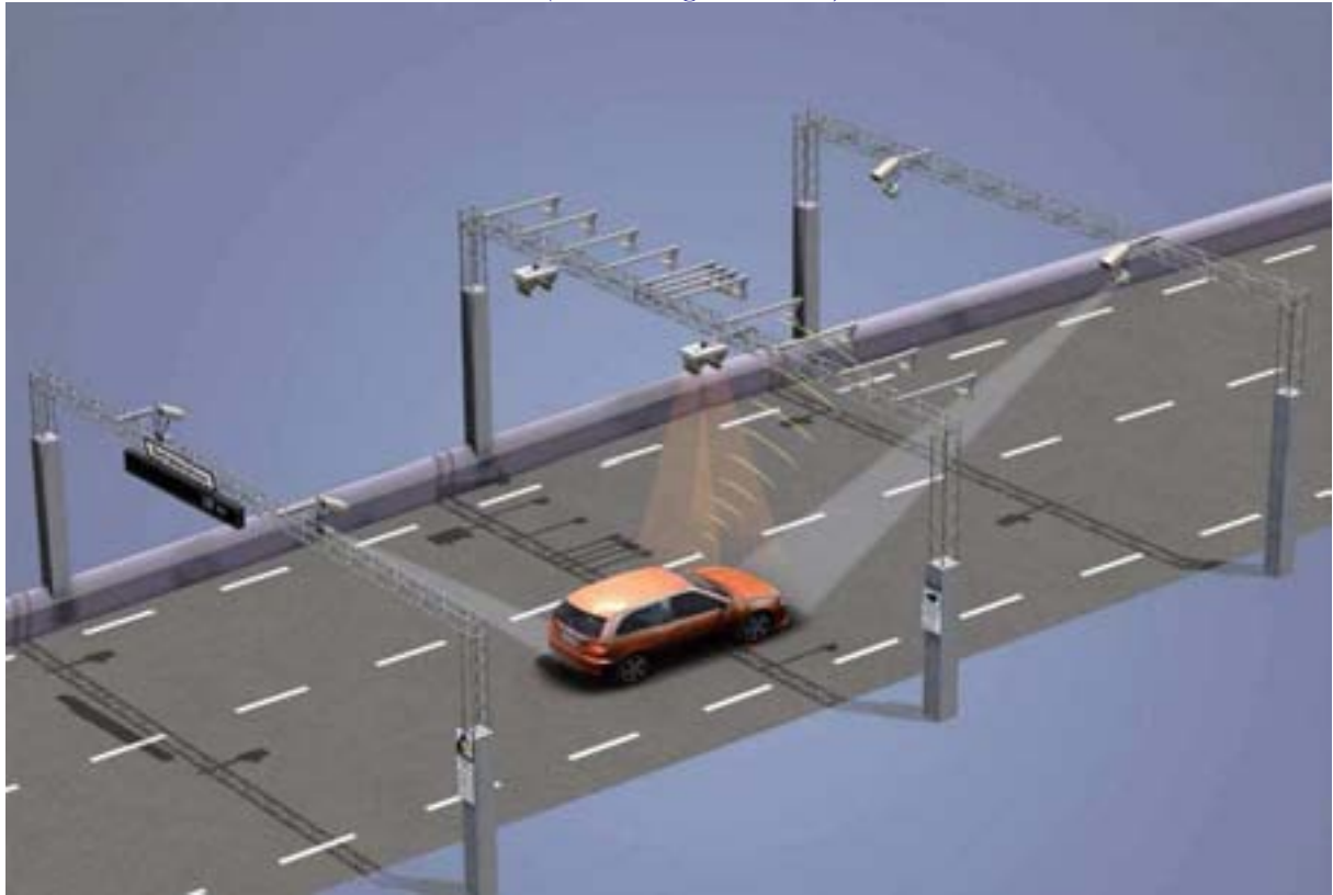
Figure 1.11 Péage de Stockholm. Les trois portiques et leurs équipements (Source : Vägverket, SRA)
