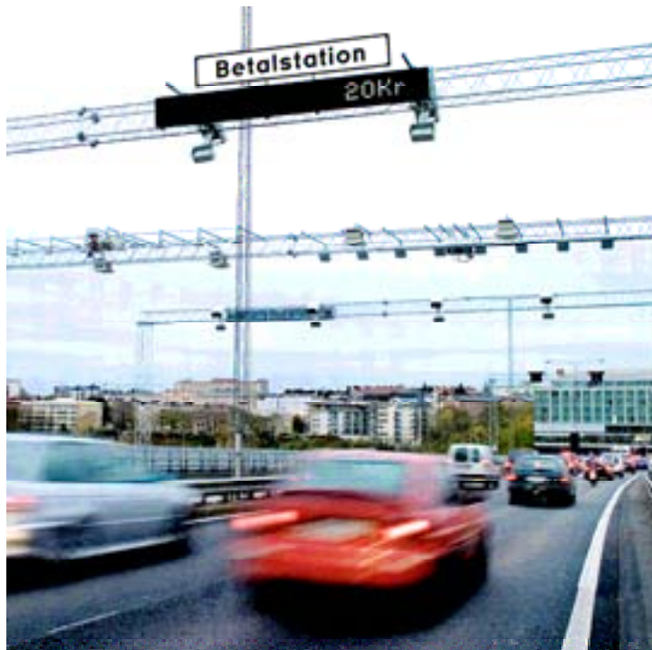
Figure 1.12 Péage de Stockholm. Premier portique franchi par un véhicule portant indication du contrôle et du prix à payer (ici 20 couronnes suédoises) (Source : Vägverket, SRA)
