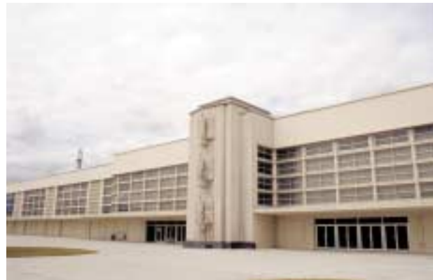
Les créateurs de l'entre deux guerres utilisent le béton pour concilier esthétique et rationalité. Les exemples remarquables sont nombreux en Ile-de-France. Aéroport du Bourget (93)
