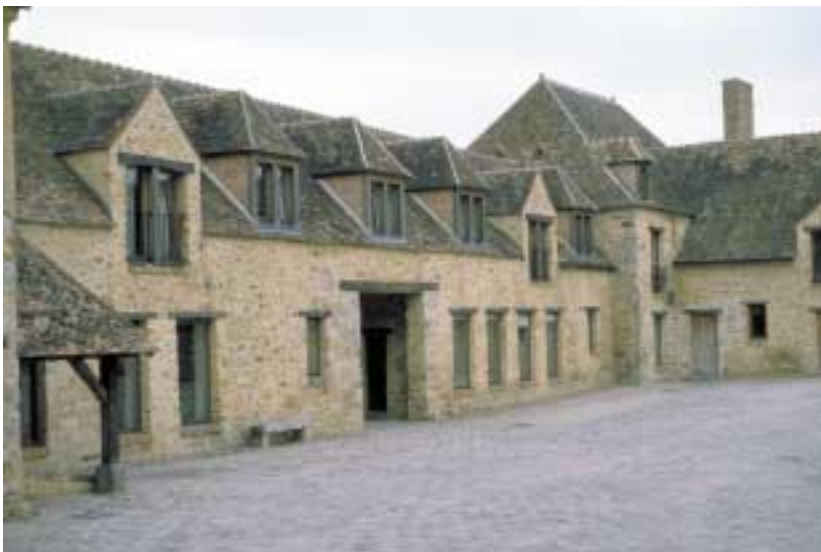
Une restauration standardisée : fenêtres mises à l'unison, une symétrie et une régularité qui n'ont rien de traditionnel. Pourtant les pierres bien traitées et les tuiles plates à l'ancienne. Domaine de Coubertin (78)
