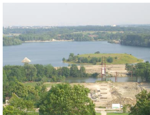
Passerelle de l'axe Majeur (aménagement en cours de la future entrée Nord)
