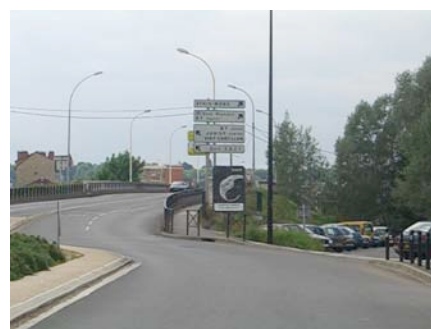
Pont routier reliant Juvisy à Draveil
