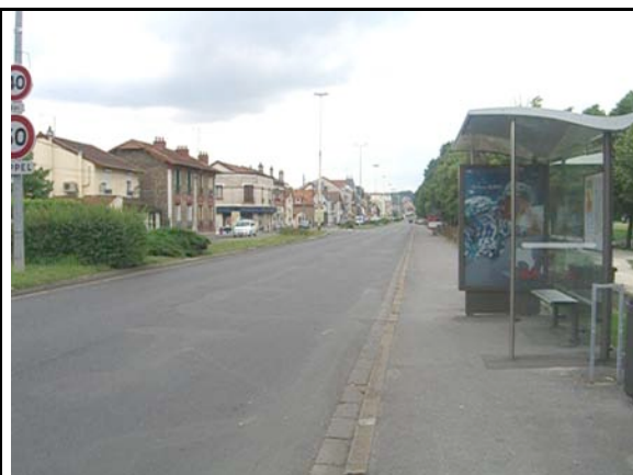
Arrêt de bus « Paris-Jardin » au Sud de la base
