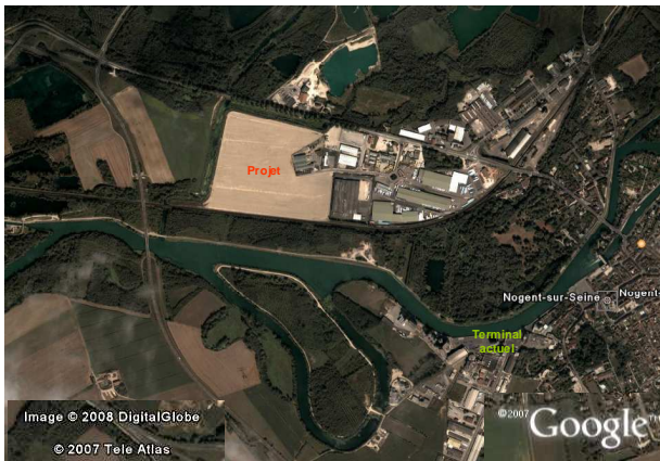
Photo 6 : vue sur le futur terminal de Nogent sur Seine
