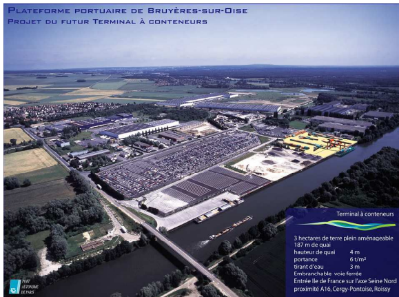
Photo 5 : le terminal de Bruyères sur Oise
