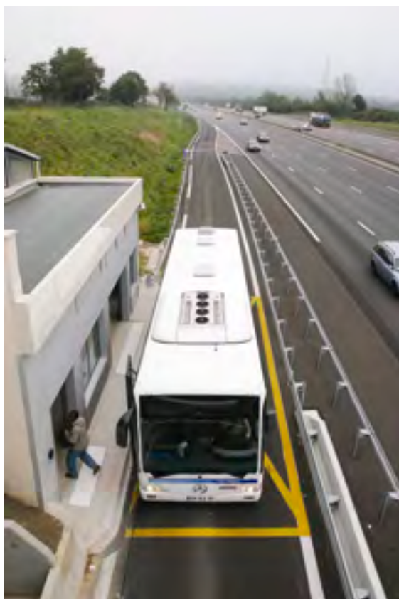
Légende : Gare autoroutière de Briis-sous-Forges, Rampe d'accès sécurisée pour le bus depuis l'A10, et entrée sur le quai, en provenance de Massy et en direction de Dourdan C. Doutré / BaSoH / IAURIF
