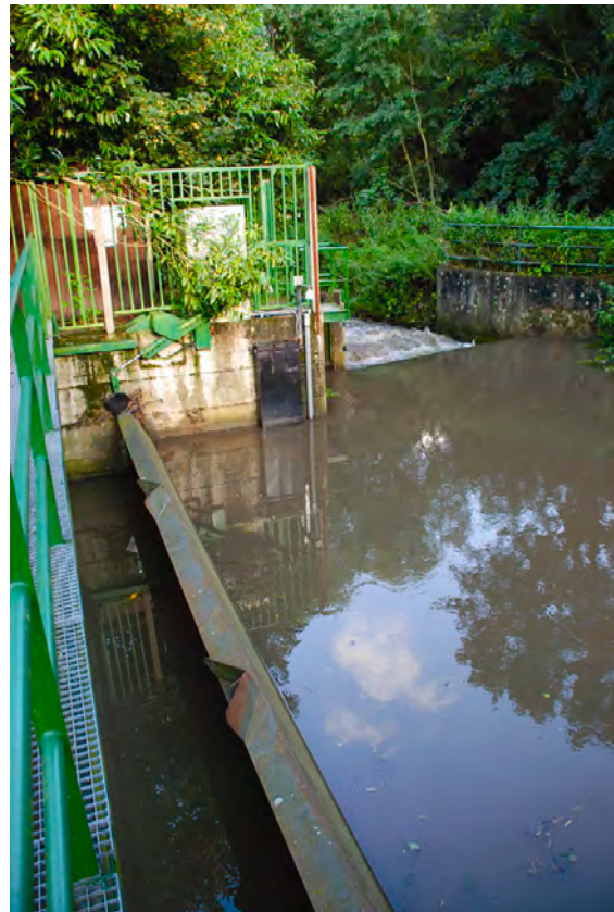
Barrage de régulation des crues de l'Yvette pour le bassin de retenue de Coupières. - B. Raoux/IAURIF
