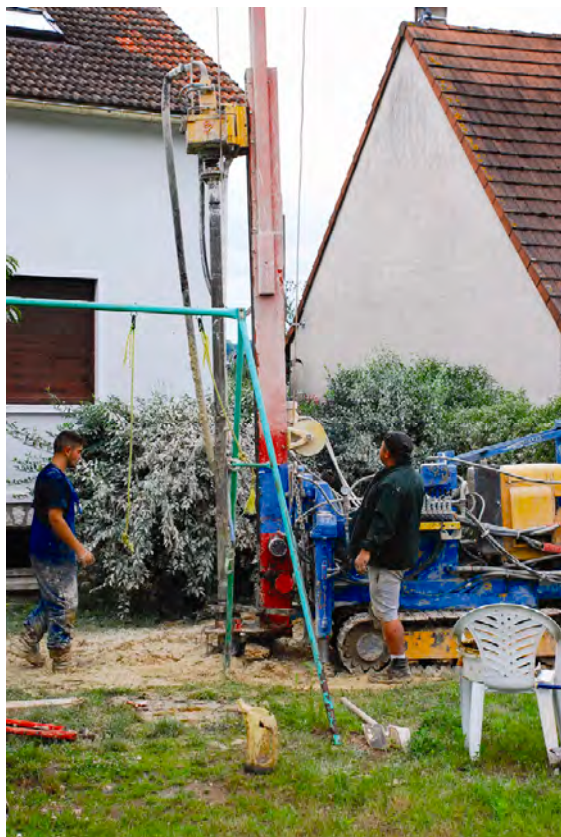
Géothermie verticale : forage à 25m de profondeur dans du calcaire poreux de bord de Seine - B. Raoux / IAURIF
