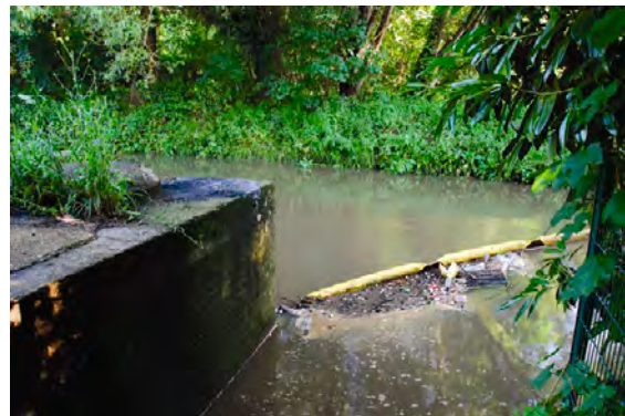
Barrage de nettoyage sur l'Yvette avant le bassin de retenue de Coupières (Gif sur Yvette) - B. Raoux/IAURIF
