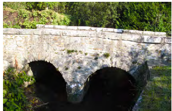
Un ponceau à double arche à Emancé M. Bourgeois/ IAURIF
