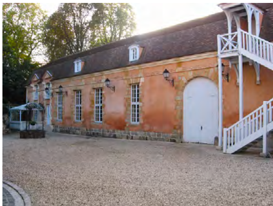
Communs rénovés pour abriter des équipements publics à Angervilliers - P. Montillet / IAURIF
