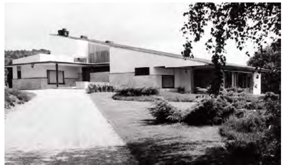
La maison Louis Carré de Alvar Aalto à Bazoches-sur-Guyonne est représentative du patrimoine du XXème siècle et classée monument historique en 1996 - J. Bruchet/ IAURIF
