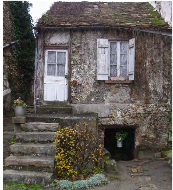
Une maison de vigneron, maison rurale élémentaire à Bris-sous-Forges – P. Montillet/ IAURIF
