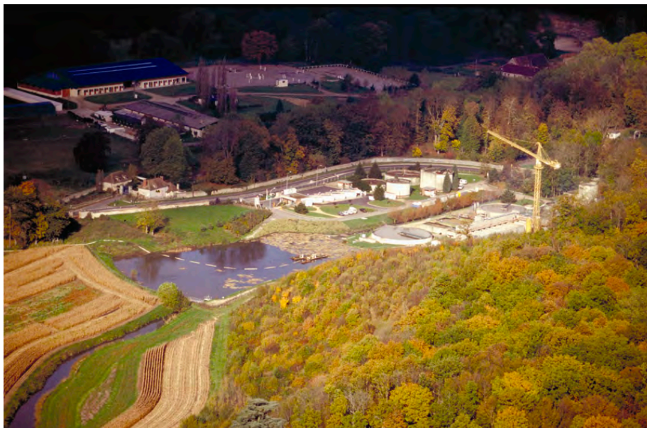
La station d'épuration de Rambouillet - H. Raguet/ IAURIF
