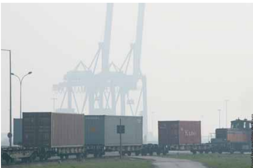
Sur le port du Havre, la massification peut s'opérer sur un chantier dédié aux transports combinés, permettant d'élargir l'offre terrestre et offrant à tous les opérateurs de transports combinés fluviaux et ferroviaires la possibilité de desservir tous les terminaux maritimes.
