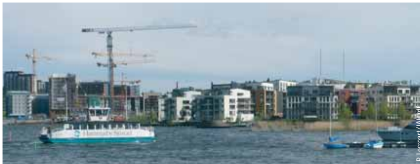
Navette fluviale du quartier Hammarby Sjöstad.
