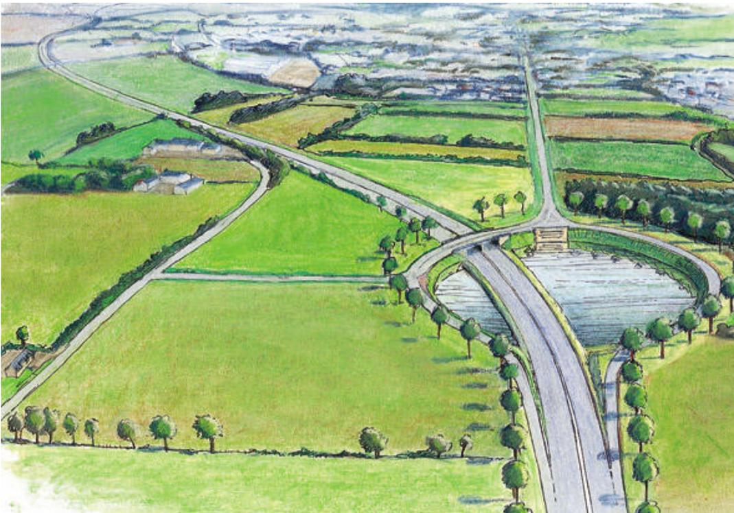
L'utilisation de l'axe existant, avec une entrée de déviation compacte et transformable en giratoire dénivelé, permet de limiter la coupure de l'espace ouvert. Cette alternative est transposable aux projets de C6 (séparation de N20 au Petit-Ballainvilliers) et d'A12 (entrée sud de Coignières, entrée nord des Essarts), elle aurait pu l'être aussi au départ de la déviation de Meaux
