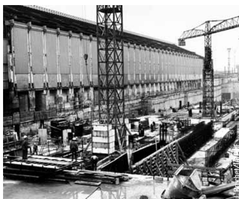
Le Sdaup a permis à la métropole francilienne de relever des défis, notamment en termes de transport, dans les années 1960-1975. Chantier de station d'interconnexion, Paris XIII e .
