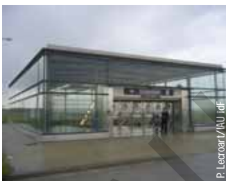
À Mosbles, le métro a été réalisé antérieurement à l'urbanisation.
