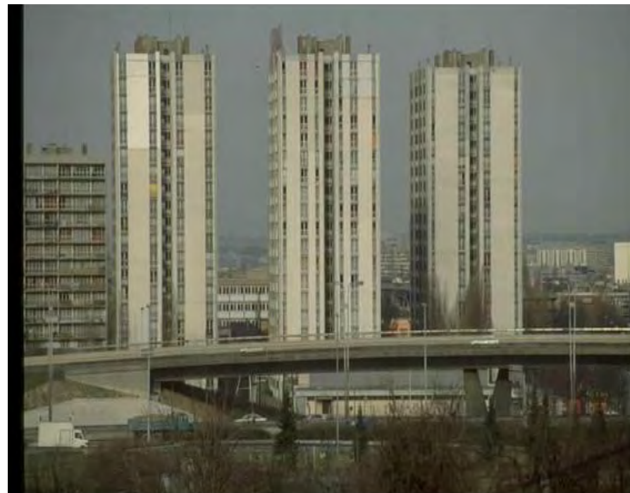
Logements à Noisy le Sec (93)
