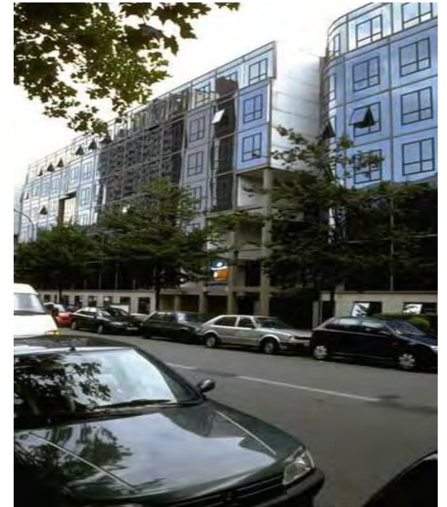
Immeuble de bureaux à Issy-les-Moulineaux (92)
