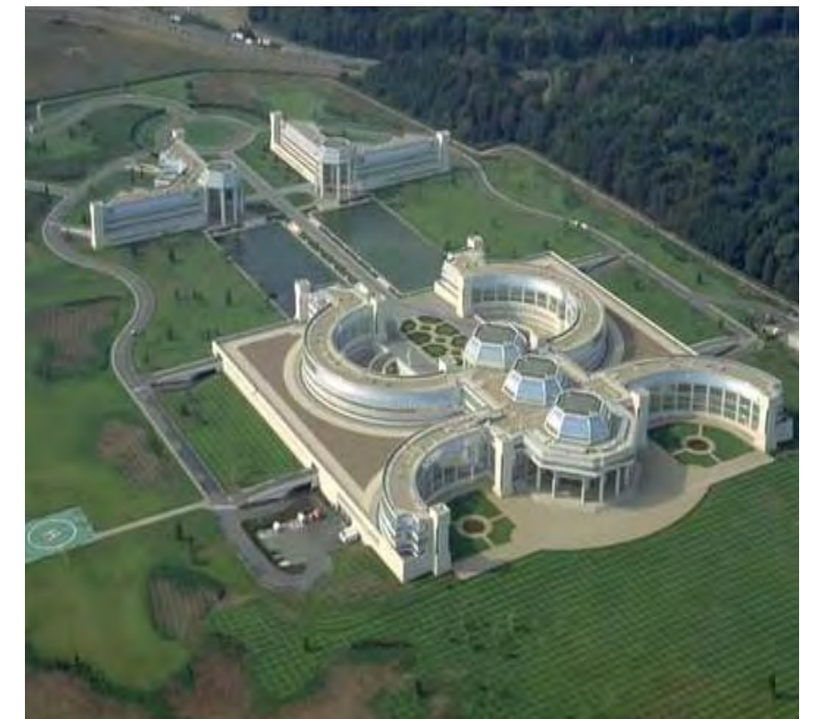
Siège de la société Bouygues à Saint-Quentin-en-Yvelines (78)
