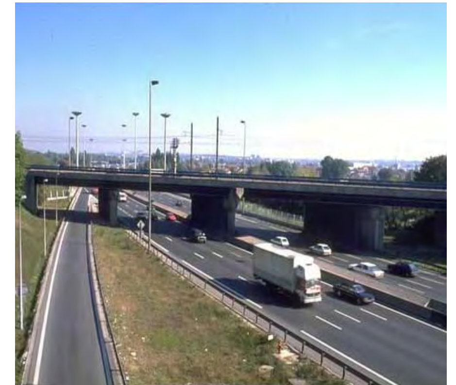
Autoroute A4 à Joinville-le-Pont (94)
