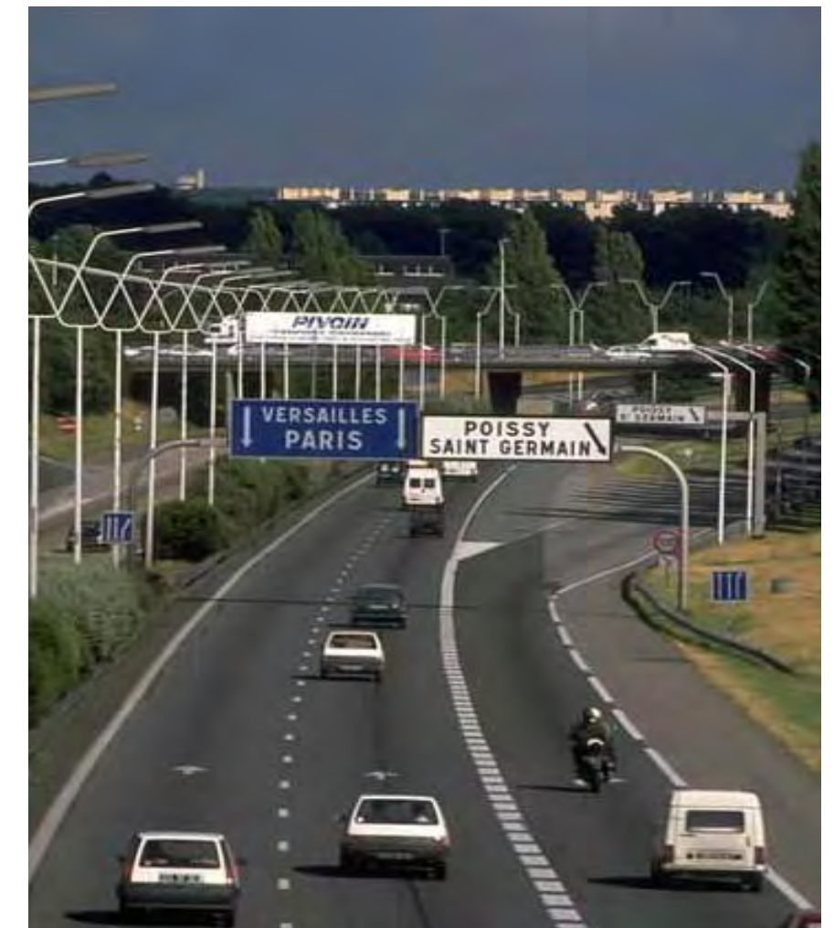
Autoroute A13 à Poissy (78)
