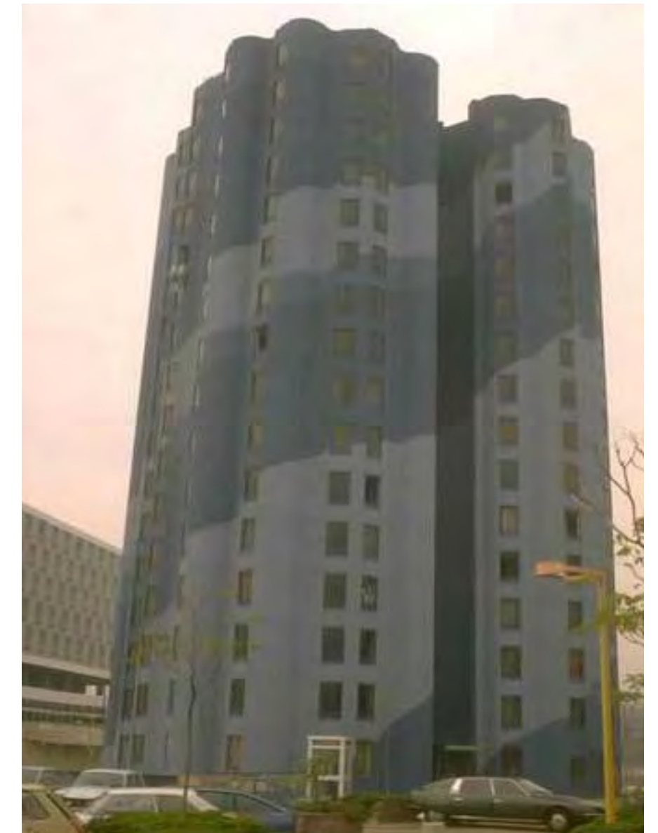
Tour de logements à Cergy-Pontoise (95)
