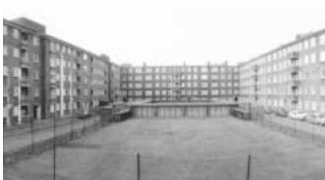
Lea View House, Hackney (Londres) : la cité avant la réhabilitation
