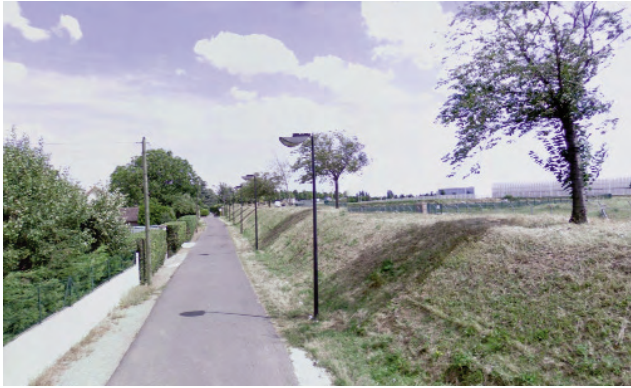
60. Talus situé entre l'aéroport et les habitations d'Orly
