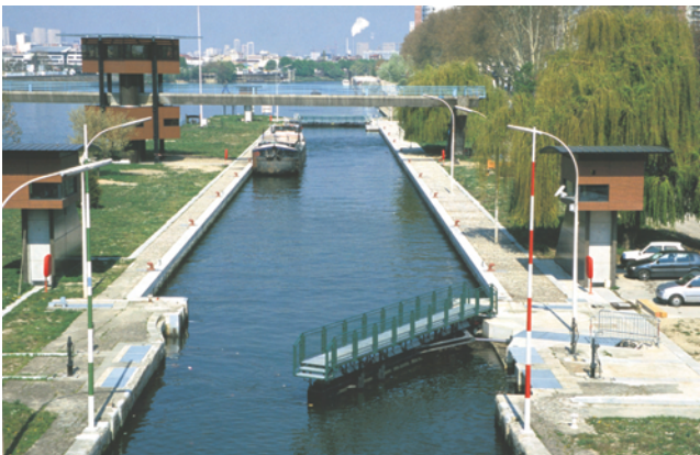
43. Ecluse de Vitry-sur-Seine
