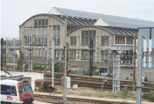
48. Halle SNCF, juillet 2009
