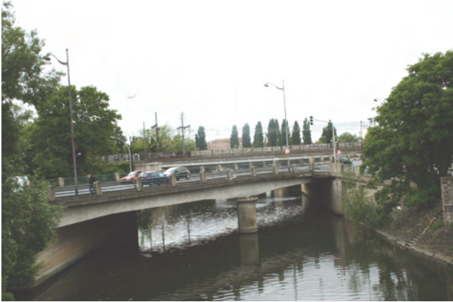
147. L'Yerres en aval du pont, un espace opprimé par les infrastructures, mai 2009
