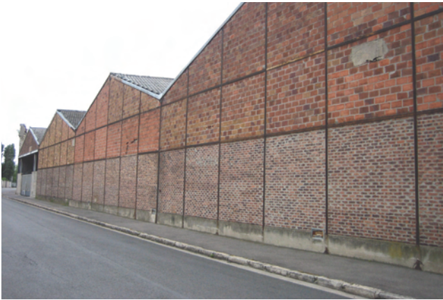
39. Mur aveugle d'un bâtiment d'activité, mai 2009
