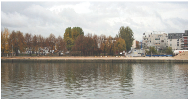
150. Aménagement des berges à Choisy le Roi, novembre 2009
