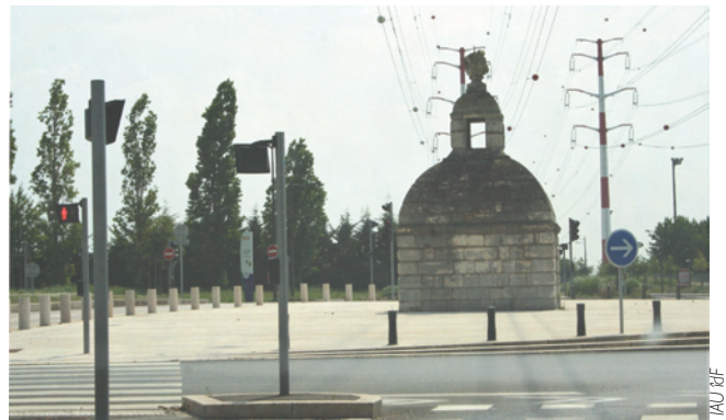
40. Regard de l'aqueduc à Rungis, juillet 2009
