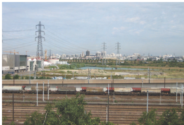
46. Emprise ferroviaire à Valenton, juillet 2009
