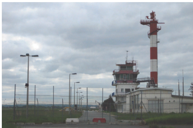
68. Tour de contrôle de l'aéroport d'Orly, 2009
