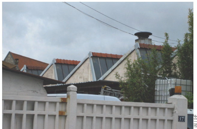
66. Toiture en shed, mai 2009
