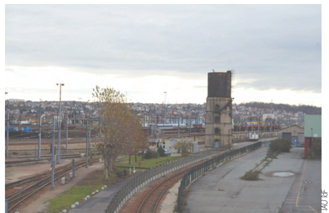
23. Un ancien château d'eau du temps des locomotives à vapeur. Un beau témoin dans un secteur où les chemins de fer ont joué un si grand rôle, novembre 2009
