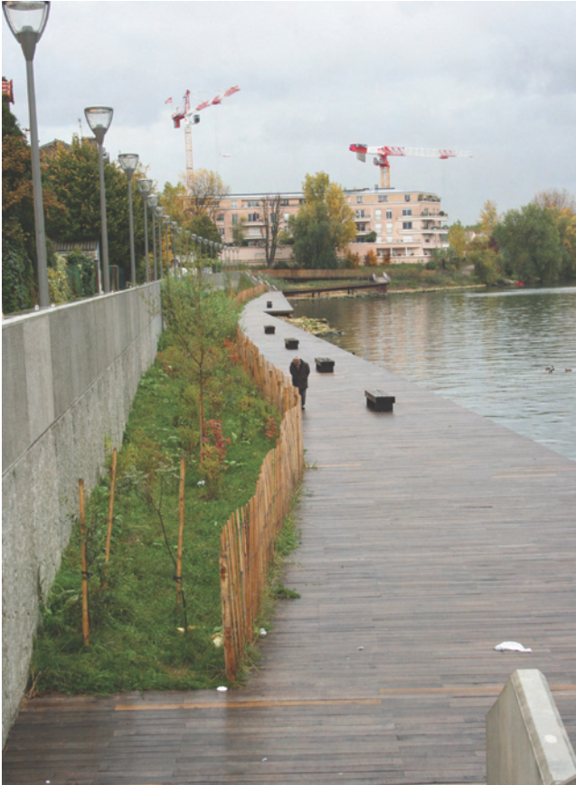
91. Berges de la Seine aménagées à Choisy le Roi, janvier 2010
