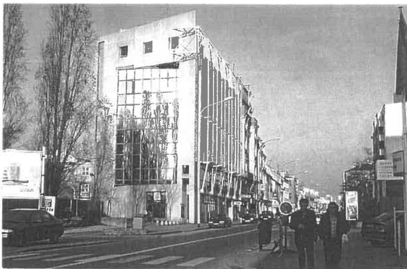
Sur la rue de Paris, l'opération d'un CAP au nord de la ZAC "Beaumarchais" : cet immeuble de bureaux protège en servant d'écran au bruit de la rue un programme de logements situé en arrière.
