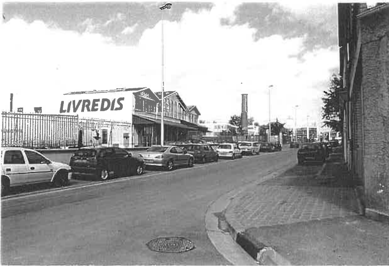
Façades arrières de Livredis et de Philips sur la rue M. Gunsbourg : au premier plan les hangars réhabilités de Livredis.
