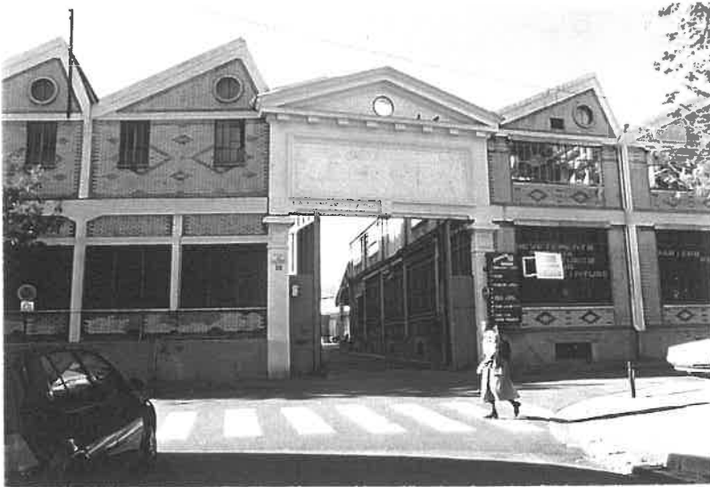
Le CAP "Fleurus" : entrée principale au 14/18 rue Kléber. Le caractère urbain de cette typologie industrielle réside dans l'alignement du bâti sur la rue. L'opération du CAP est une réhabilitation légère des bâtiments pour l'accueil de plusieurs entreprises.
