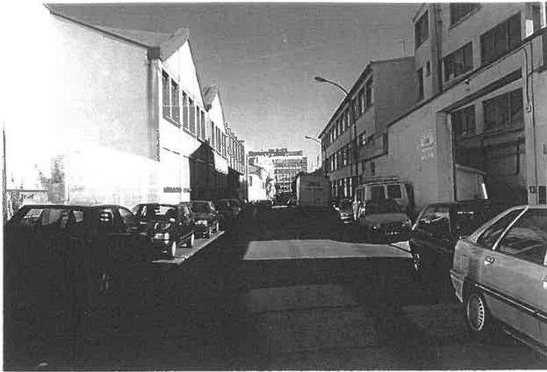
Les arrières de la ZAC "Tampon" au nord, rue du Progrès, vue vers l'est : un exemple de rue "industrielle", avec à gauche les établissements Pilliard (construction métallique) et, à droite la résidence d'entreprises (2ème phase du CAP "Valmy" par réhabilitation d'anciens locaux d'activités).
