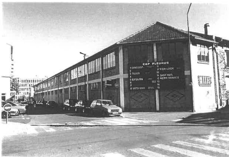
Le CAP Fleurus à l'angle nord-ouest sud-est des rues du Sergent Bobillot et Girard : les bâtiments sont accessibles uniquement par la cour. Le bâti ne dépasse pas la hauteur du tissu pavillonnaire (R+1 et combles)..
