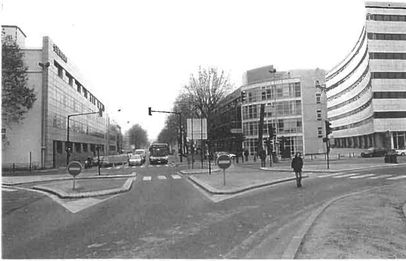
Croisement du bd. Ornano et de la rue du Dct. Finot : à droite l'opération de l'Axe Pleyel face au bâtiment Siemens. Les bureaux sur le boulevard restent de faible hauteur (R+3), ceux à l'arrière montent jusqu'à R+6, avec entre les deux un passage et une place intérieure donnant accès au square.
