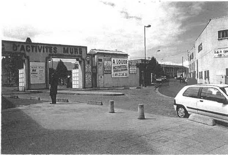
Entrée principale du parc d'activités "Mure" située 128 et 128 bis avenue Jean Jaurès : le retrait de la ZAE par rapport au boulevard nécessite une importante signalétique.
