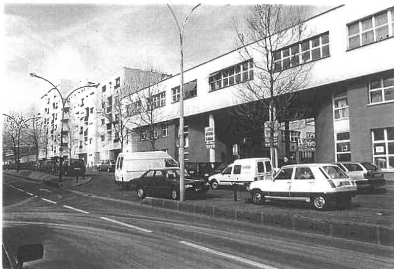
Façade sud du CAP "Valmy" et contre-allée. L'opération du CAP reprend une modénature de façade industrielle traditionnelle et s'organise autour d'une cour centrale desservant les différentes entreprises. La voie publique avec sa contre-allée permet de séparer les flux, de régler le stationnement et d'agrémenter l'espace public de plantations d'alignement.
