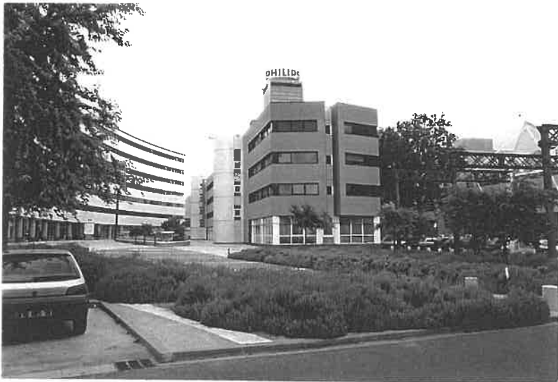
Le square, vue prise depuis la rue de la Torpédo : centre et articulation de l'opération, cet espace public permet une traversante à l'îlot d'est en ouest. Entre les bâtiments, le passage et la cour précités donnent accès à la rue du Dct. Finot.
