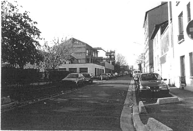
La rue Elisabeth, vue depuis la rue J.J. Rousseau : l'opération de logements-ateliers et son tissu environnant composé d'im-meubles R+3/R+4, de pavillons et d'un espace public.
