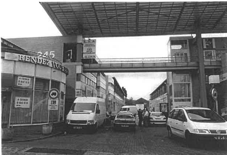
Entrée Est des EMGP : la fermeture de l'enceinte est marquée par la passerelle et l'auvent.
