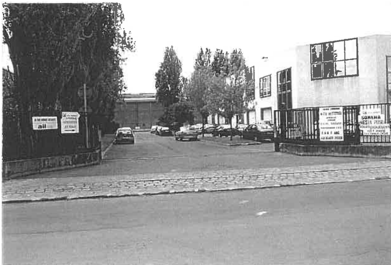
26 rue R. Witchitz, l'entrée visiteurs. Bâtiments "types" proposés dans les ZAE nord et sud de la zone "Mure" : un rez-de-chaussée pour les activités et un 1er. étage en bureaux.
