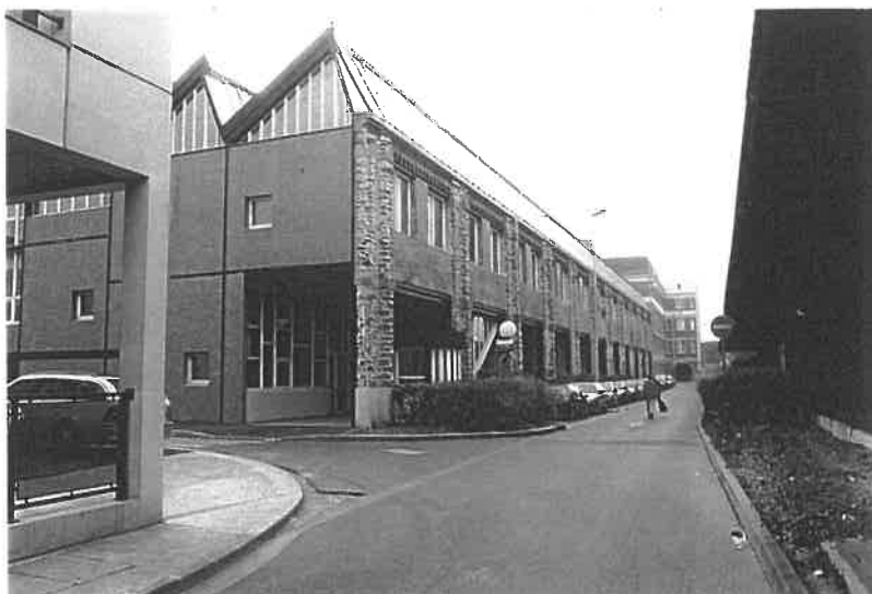
Rue des blés, vue ouest vers l'avenue Wilson entre les imprimeries de la Plaine et la halle métallique réhabilitée. Cette opération propose des locaux d'activités et de bureaux en arrière et sur l'avenue en ensemble tertiaire.
