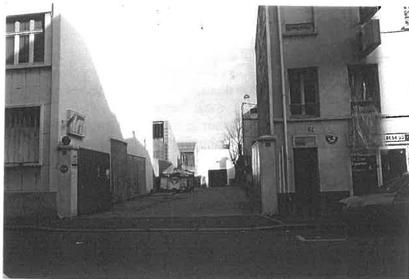
66 rue de Lagny, arrière de LRI-OCE France : la parcelle traversante trouve un accès de service direct pour ses entrepôts situés en coeur d'îlot.
