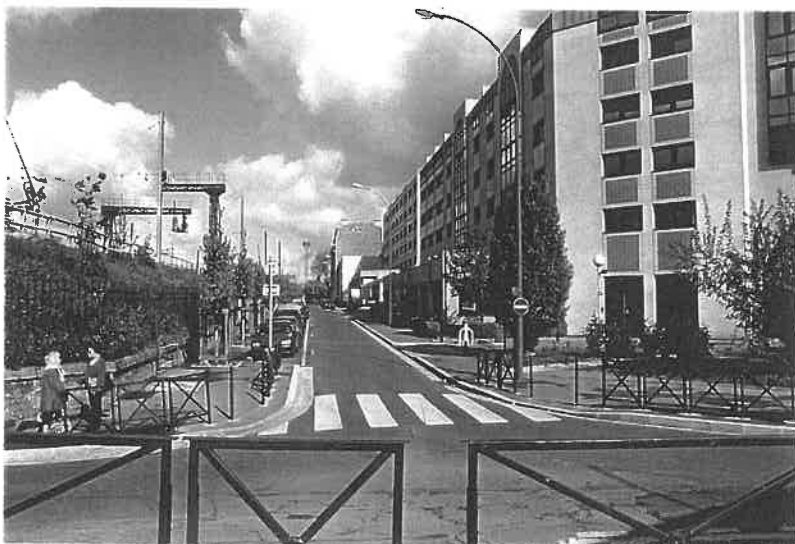
A l'ouest l'alignement des façades est souligné au niveau de l'espace public par des plantations qui s'alternent avec du stationnement.
