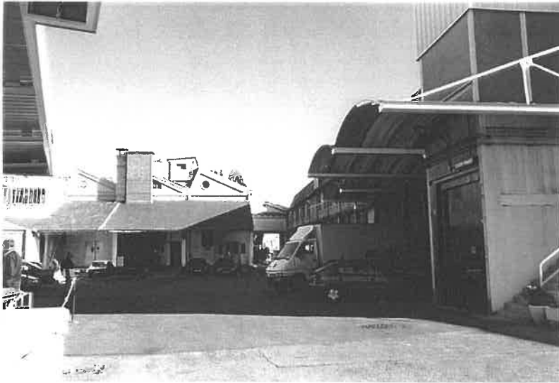
Le CAP "Fleurus" : les activités sont desservies par la cour centrale. La réhabilitation consiste en un aménagement minimum avec une mise en lots des bâtiments et quelques marquises sur les quais de déchargement.
