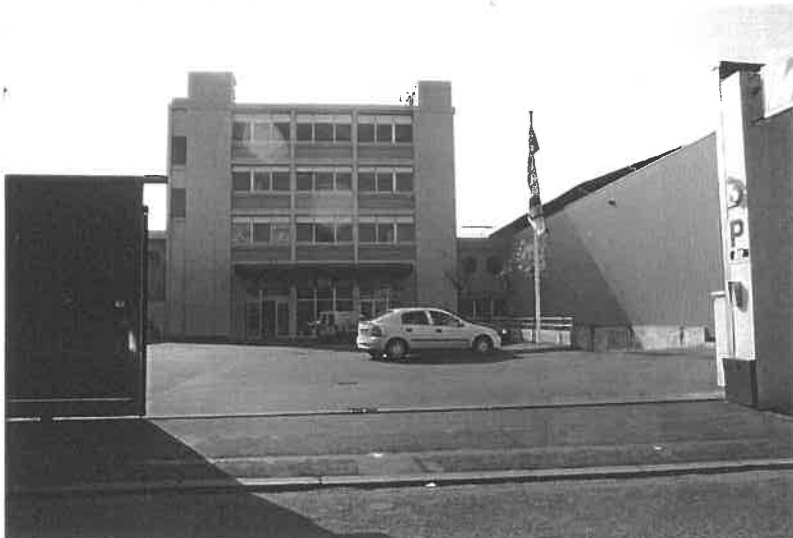
27 rue Cuvier, façade nord d'"OCE France" : reprise des modénatures et de l'organisation de la typologie industrielle. L'opération utilise aussi le sous-sol pour son stationnement .
