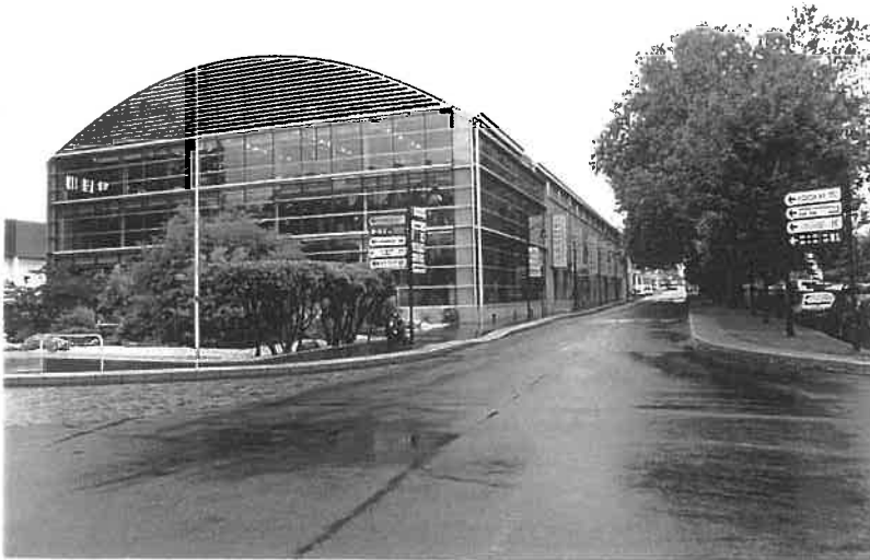
"La City", bâtiment 134, vue prise depuis l'axe sud : exemple de rénovation et de réhabilitation du bâti des EMGP, de l'aménagement de l'espace public.
