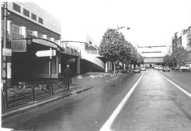
Façade sud de l'îlot sur la rue de Westermeyer : la façade aveugle, les accès verticaux à la dalle et les sorties de parking ont un impact très fort sur l'espace public. La rue devient un corridor de circulation. Avec la passerelle de la galerie commerciale la perspective est perdue.
