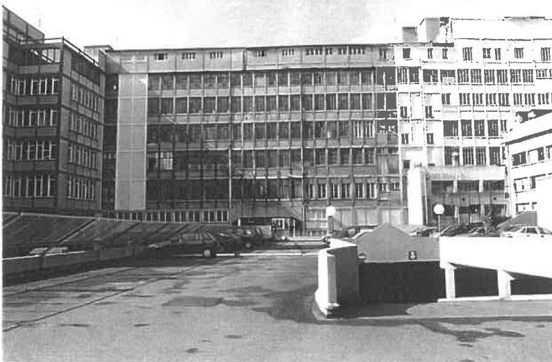
Intérieur de l'îlot, cour commune des CAP 1 et 2 : le coeur d'îlot est ici utilisé pour le stationnement des voitures avec un parking sur dalle.
