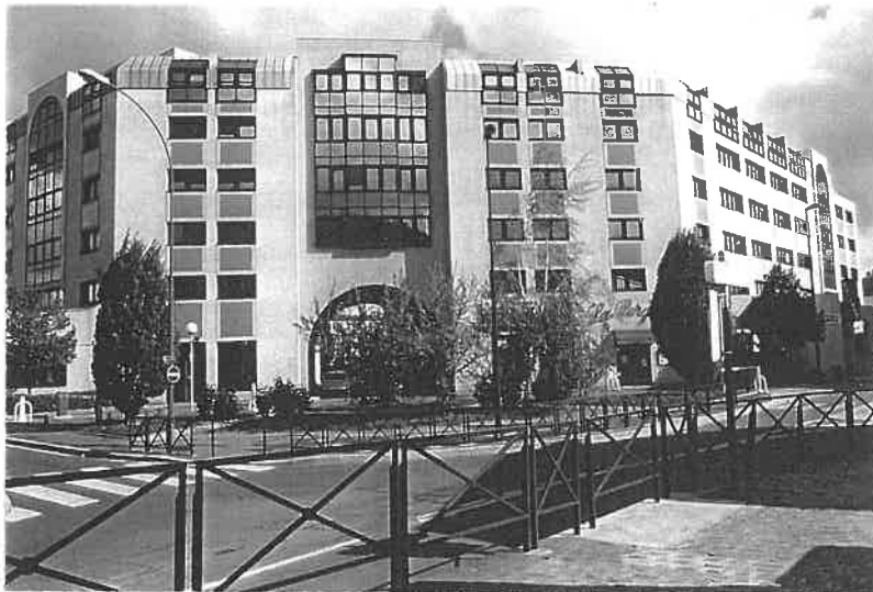
Croisement des rues M. Grandcoing et D. Papin : l'îlot s'ouvre sur la rue par un porche monumental devant un espace public planté.
