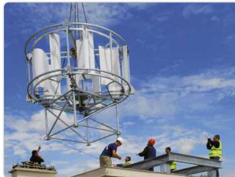
**Pose d'une éolienne sur le toit d'un immeuble à Fontenay-sous-Bois (94).**
