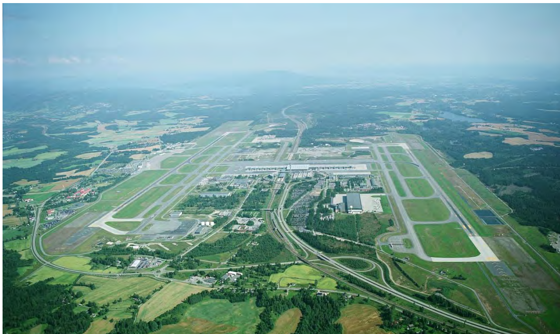
Vue aérienne de l'aéroport d'Oslo – Gardermoen Source : Oslo Lufthavn AS
