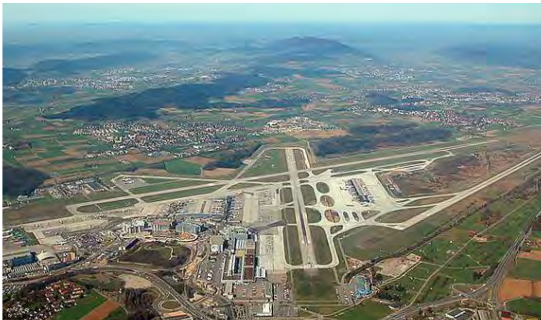
Vue aérienne de l'aéroport de Zurich Wikipedia
