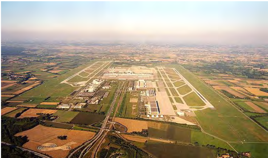
Vue aérienne de l'aéroport de Munich - Franz Joseph Strauss ©FMG
