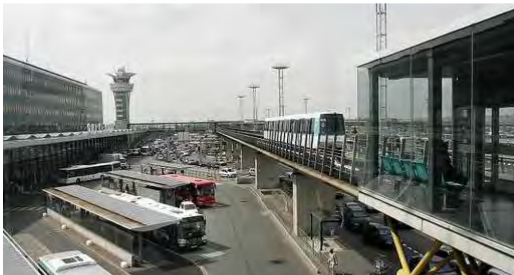
Station Orlyval et gare routière de l'aérogare Sud Crédit photo : IAU îdF ;BaSoH ;Doutre
