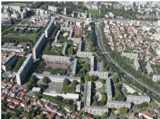
Vue aérienne le Chaperon Vert à Arcueil-Gentilly CAVB
