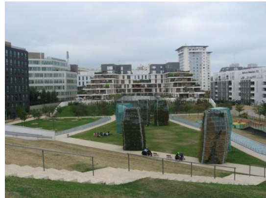
Arcueil, vue du centre commercial de la vache noire, nouveaux ensembles résidentiels, bâtiment Orange B. Guigou, IAU îdF
