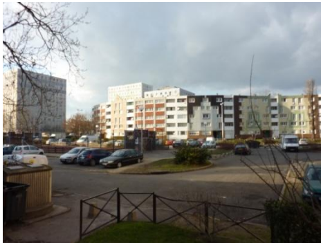
Clos Saint-Lazare : bâtiments et espaces extérieurs P. Lecroart, IAU.
