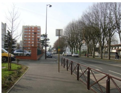
Coteaux de l'Orge, réaménagement de voiries B. Guigou, IAU îdF
