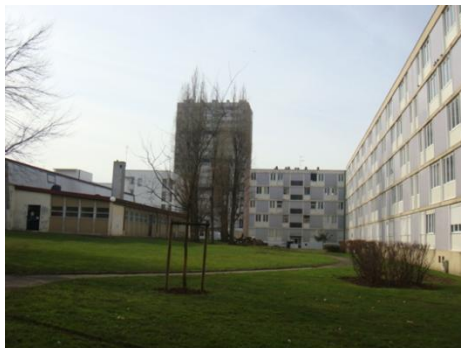
Les Coteaux de l'Orge, espaces extérieurs et bâtiments B. Guigou, IAU îdF
