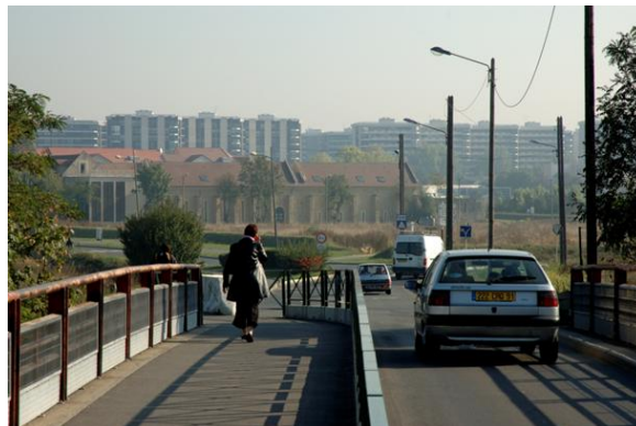
Grigny, passerelle d'accès de la Grande Borne vers le RER D et Grigny 2 JC Pattacini, IAU-idF
