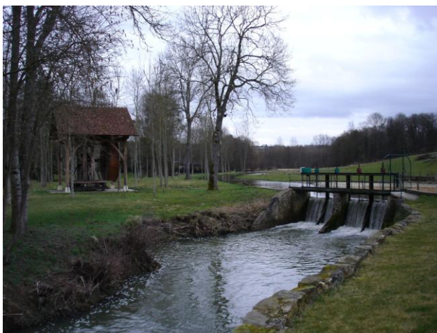
Vannage sur le Petit Morin à Verdelot (77).
