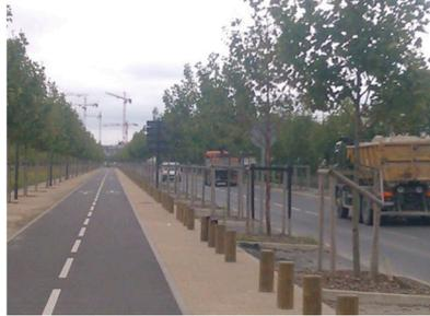
Recalibrage à 2\*1 voie et insertion d'une piste bidirectionnelle, Valenton
