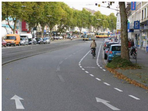
Réduction de la largeur des voies voitures et insertion d'une bande cyclable, Karlsruhe
