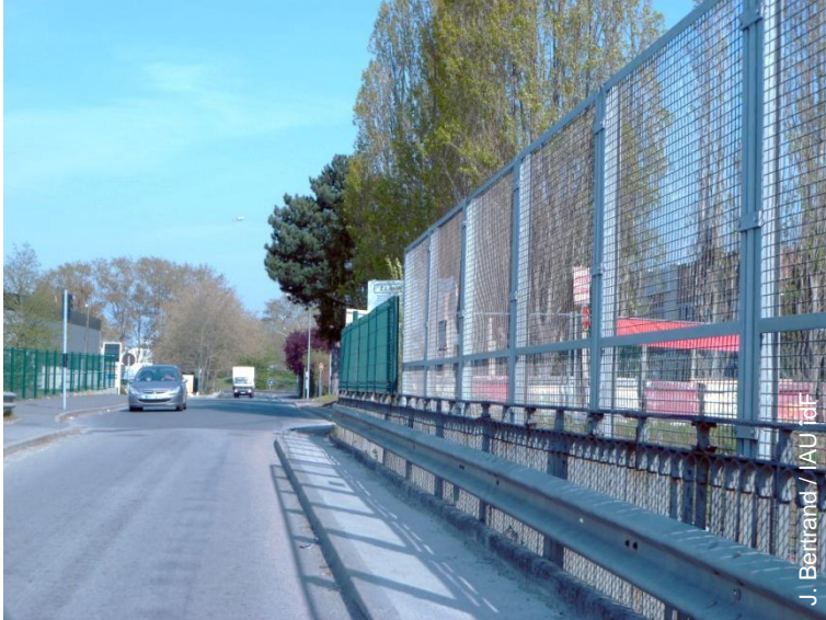
Passage réduit au franchissement des voies ferrées
