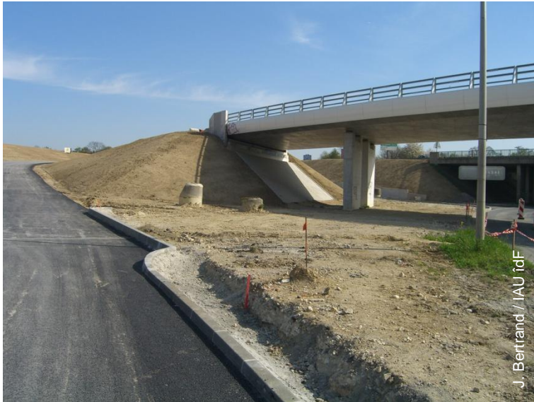
Travaux d'élargissement de la Francilienne au droit du PAE
