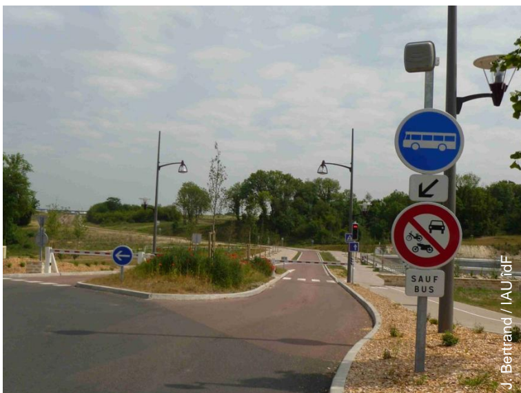
Voie réservée aux bus entre la gare et le PAE
