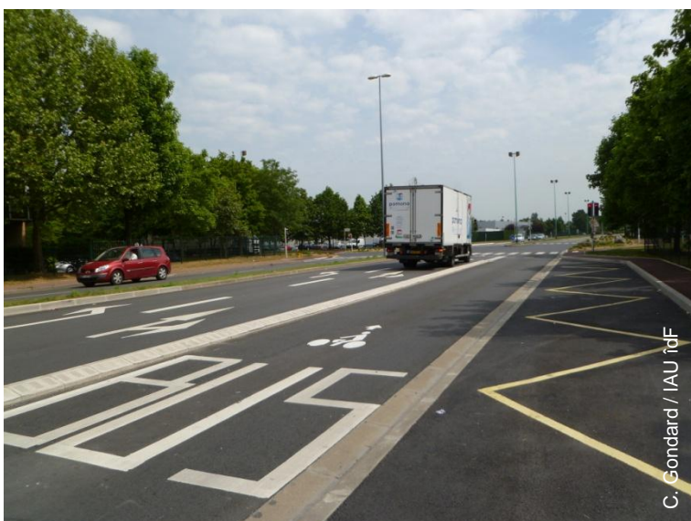
Couloir de bus aménagé au sein du PAE
