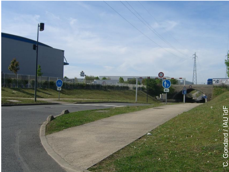
Aménagement cyclable et piétonnier au sein du PAE
