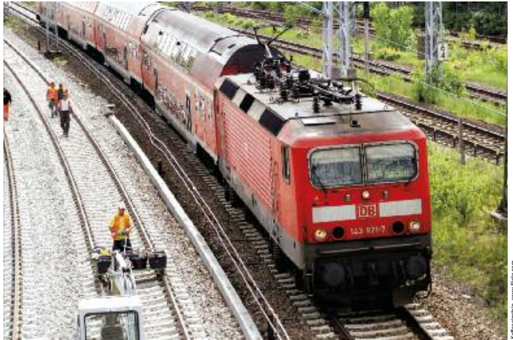
Sur le futur réseau Nord-Sud de la S-Bahn, les chantiers se succèdent.
