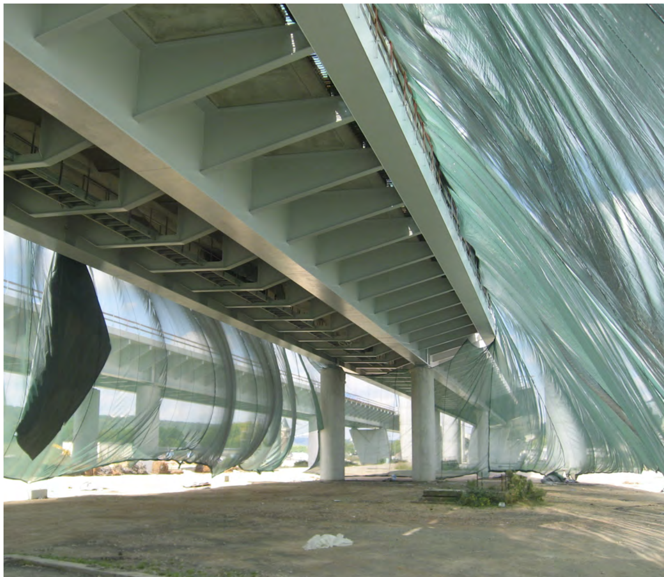
Rouen 6ème Pont - construction septembre 2007. © AGA
