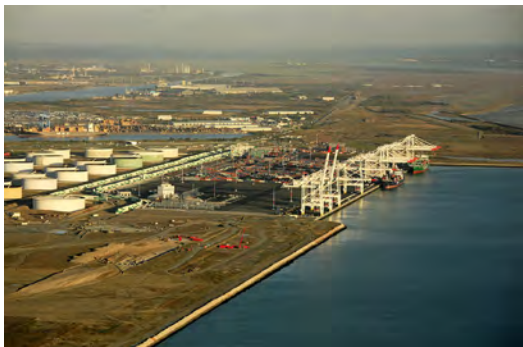
Port 2000 à connecter avec la Seine © A.Daubry
